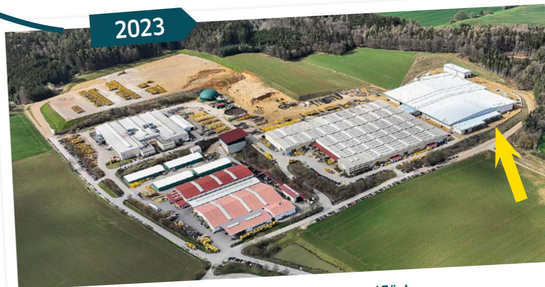
Neue Halle mit 24 500 m 2 Grundfläche
