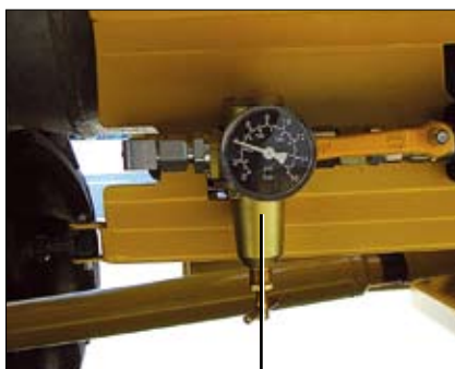
Druckminderer für die Wassersprühanlage
